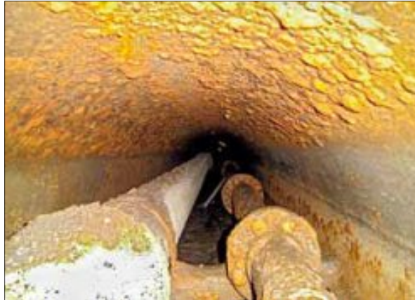
So sieht es im Düker aus, noch ohne Leitungsbündel
