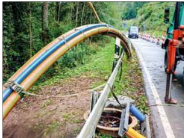
Diese Leitungen mussten durch den Düker gezogen werden
