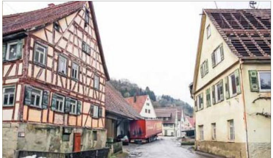
Der Straßenzug, wie er sich auf dem Bild (ebenso wie auf dem Titelbild) noch darstellt, wird bald Vergangenheit sein. Mit dem Abbruch von insgesamt etwa 11.000 m 3 Gebädekubatur wird der Weg für die lang ersehnte Innenentwicklung freigemacht
